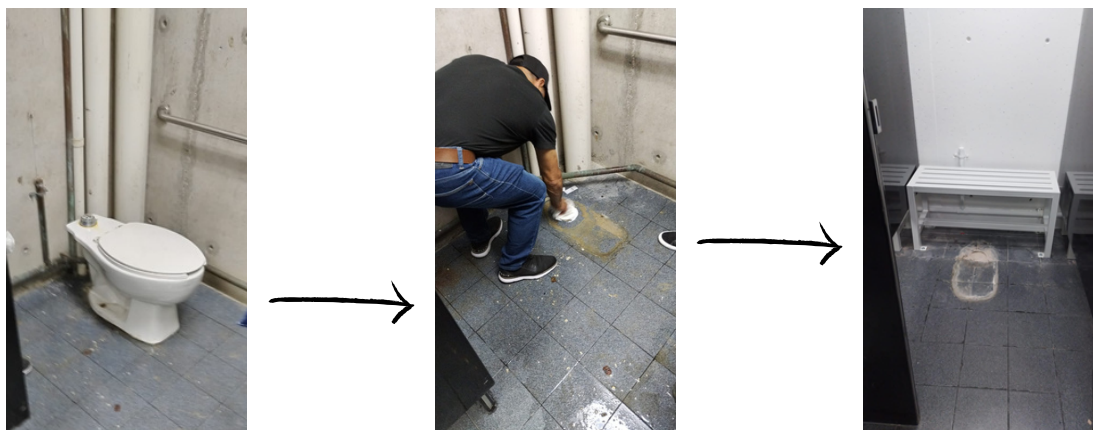
Adecuación del espacio
